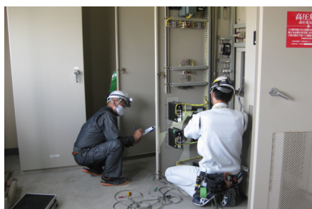
木津揚水機電気設備点検(機能診断)
