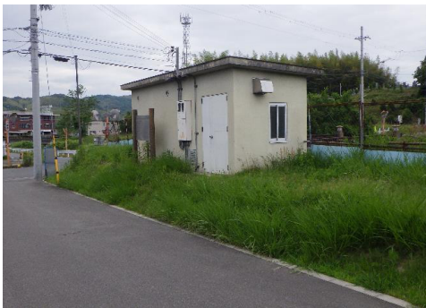
第 1 分水工(城山台 1 丁目-2-1)
